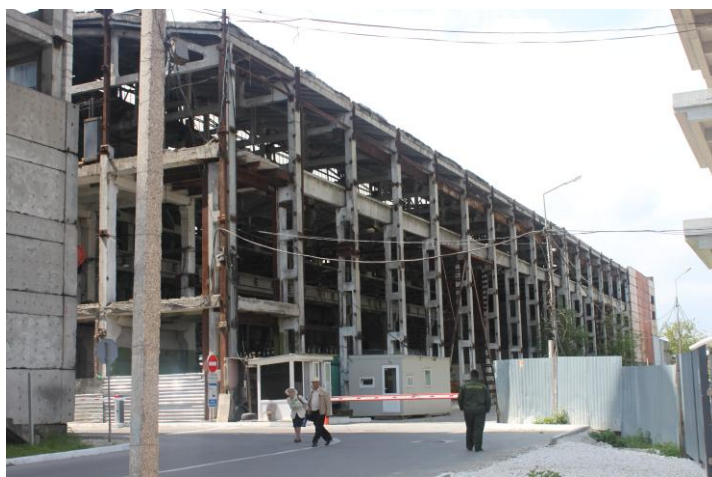
Figura 3. Clădire parțial demontată a Uzinei de Tractoare „ TRACOM ”
